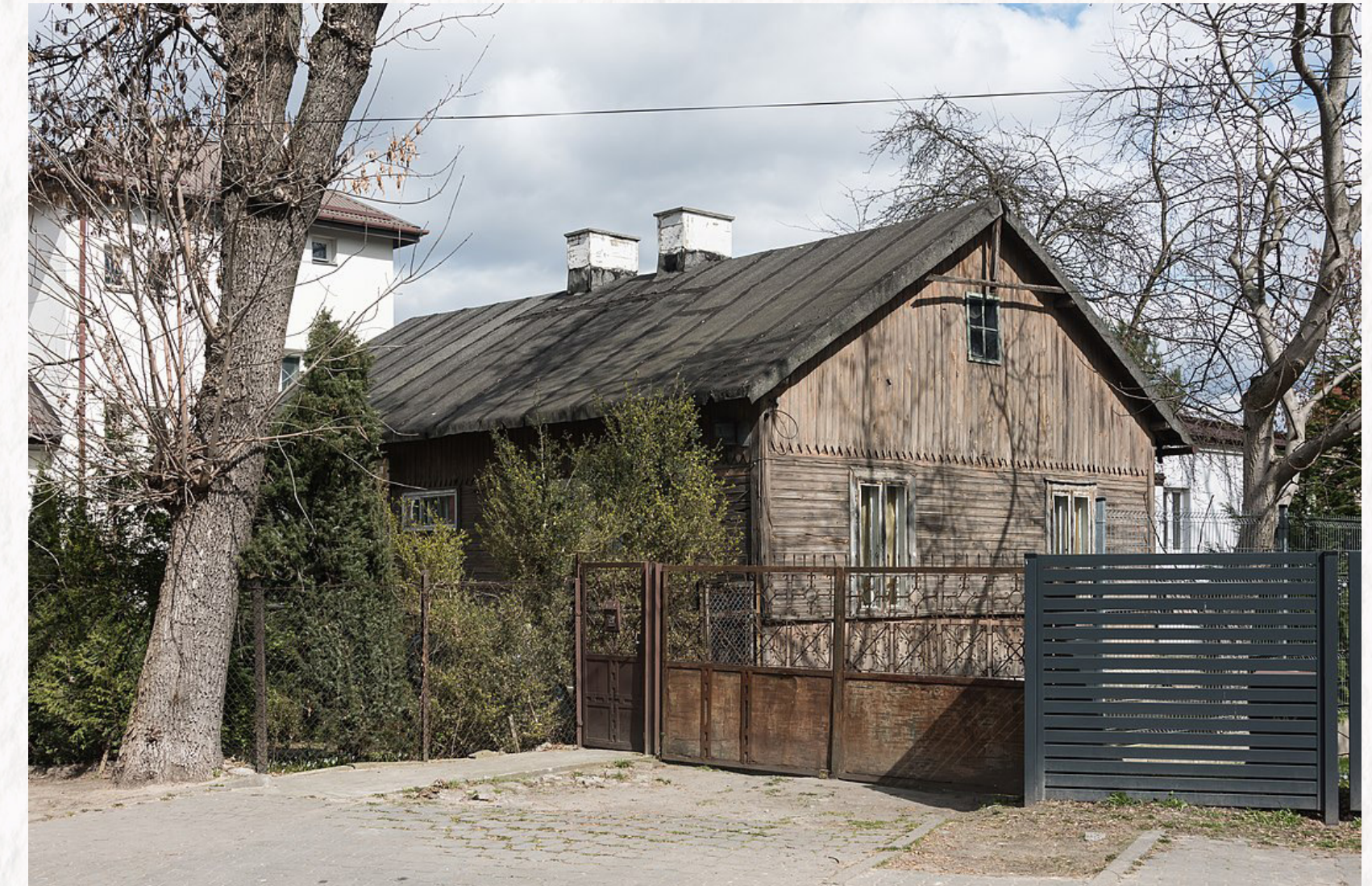
Drewniany dom przy ul. Nowoursynowskiej 152, relikw zabudowy wsi Wolica fot. Adrian Grycuk (CC BY-SA 3.0 PL)
